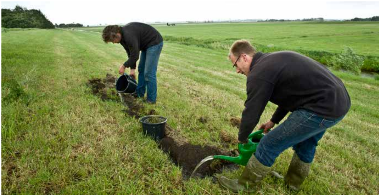
Medewerkers van een aannemer repareren met aarde en water scheuren in de veendijk langs de Zweth bij Den Hooft. De scheuren zijn ontstaan door langdurige droogte.
